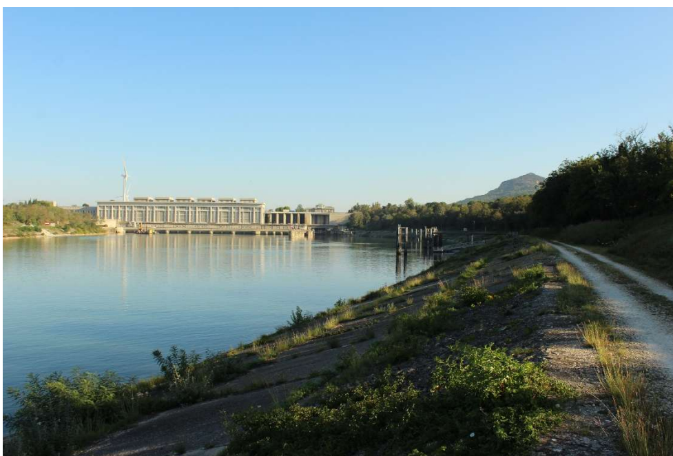
Figure 8. Vue du garage aval de l'écluse de Bollène vers l'aval (ACME, 2025)
