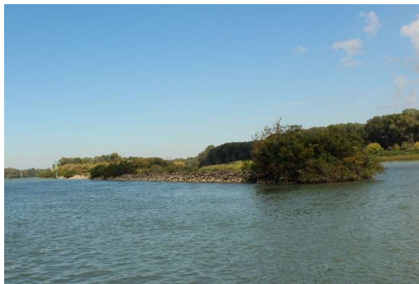
Figure 6. Digue Girardon rive gauche
