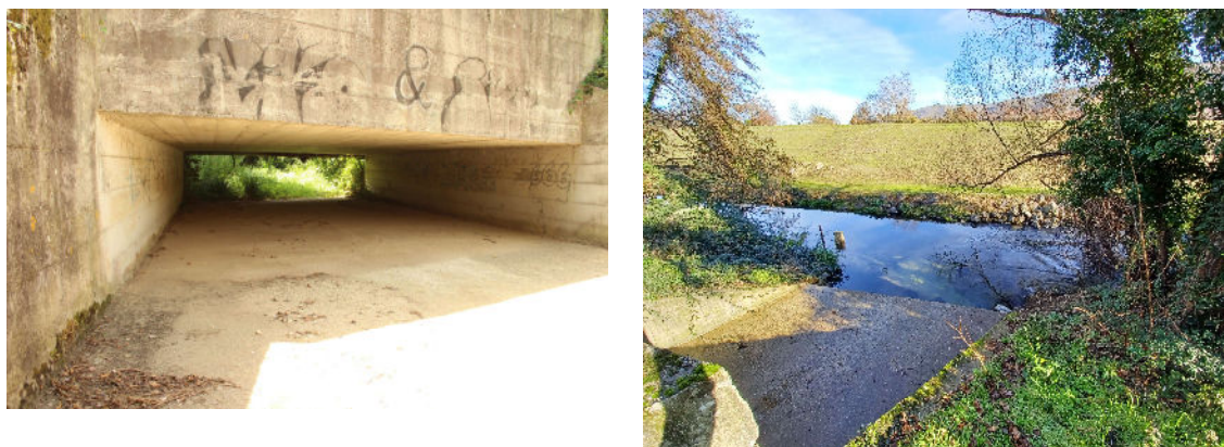
Figure 8. Vue de l'ouvrage cadre depuis l'aval et du contre-canal depuis l'ouvrage cadre (ACME et CNR, 2025)
