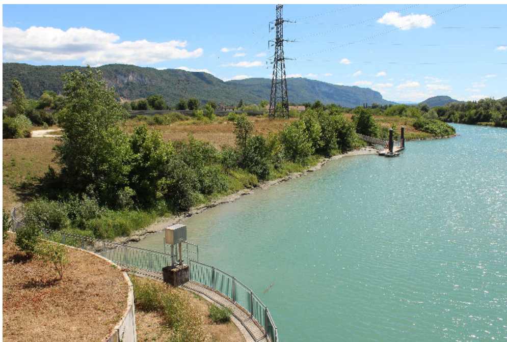
Figure 10. Vue sur le garage aval de l'écluse de Belley (ACME 2025)
