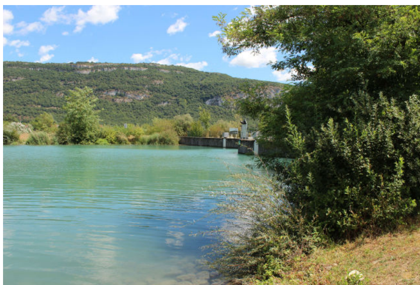
Figure 8. Vue sur le garage amont de l'écluse de Belley (ACME 2025)
