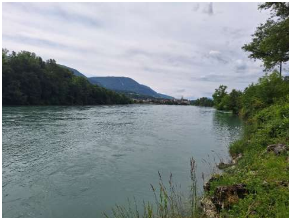
Figure 5. Rhône en aval immédiat du barrage-usine de Seyssel - Section amont du site de restitution - CNR 2026
