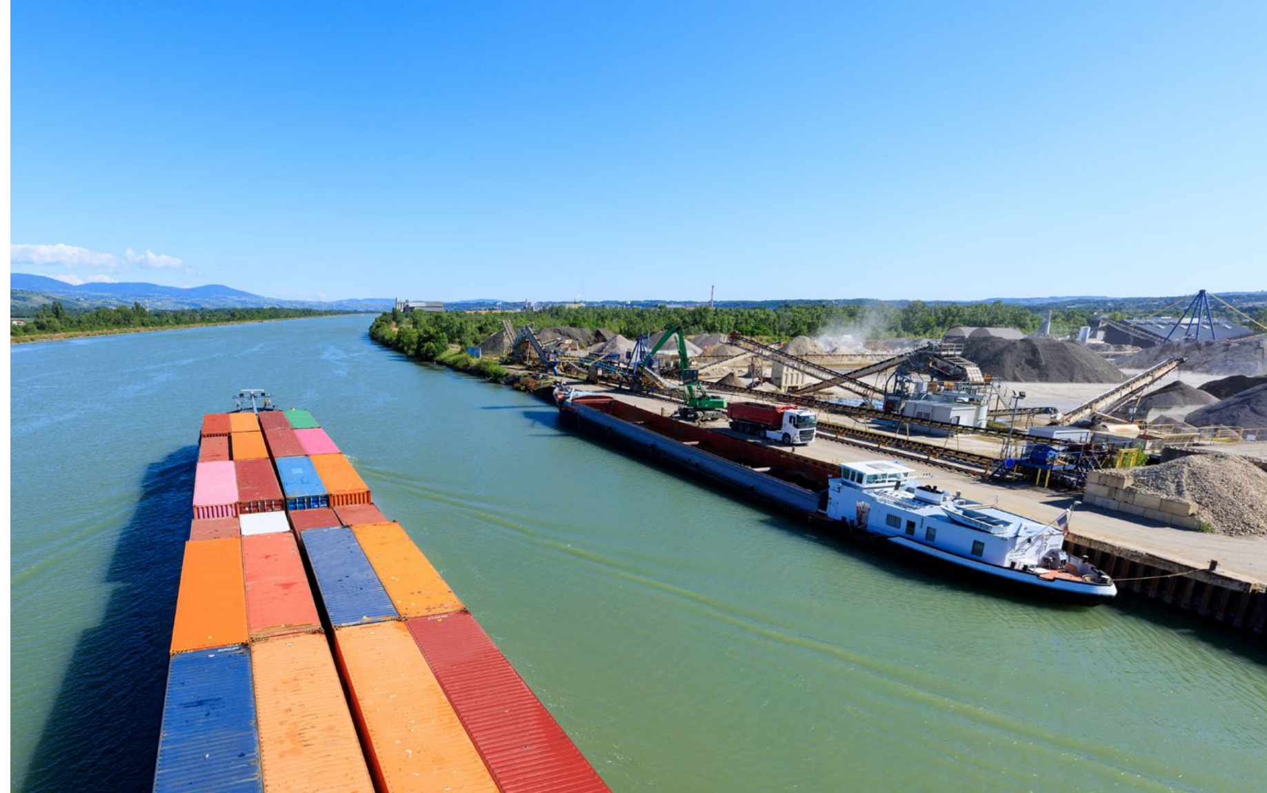
Site industriel et portuaire de Salaise-Sablons (38)
