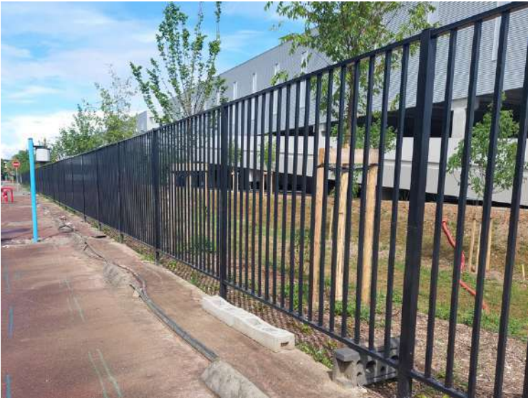
Clôture métal grise permettant le passage de la faune sur les côtés des parcelles visibles depuis les espaces communs du port ainsi qu'entre les parcelles amodiées
