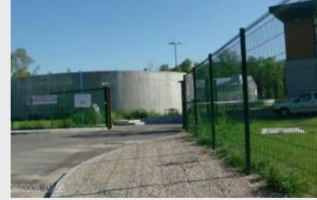
Exemple d'accès en retrait (Portail d'accès à la STEP de St Vallier) : Le portail et la clôture sont traités avec les mêmes matériaux de couleurs identiques
