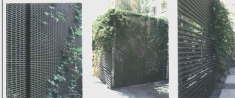
Illustration de locaux techniques
