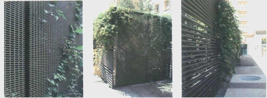
Illustration de locaux techniques
