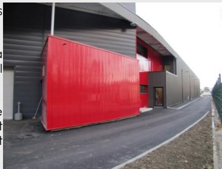
Exemple de bâtiment aux façades grises. Une boîte traitée en bardage rouge vient articuler les 2 blocs du bâtiment
