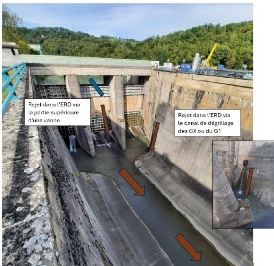
Figure 12. Restitution dans l'évacuateur de crue (Vue amont)
