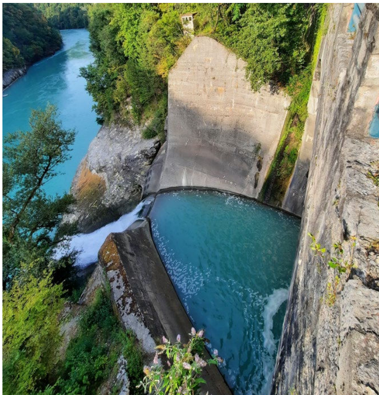
Figure 15. Bassin de dissipation d'énergie au pied du « saut à ski » et restitution au Rhône.
