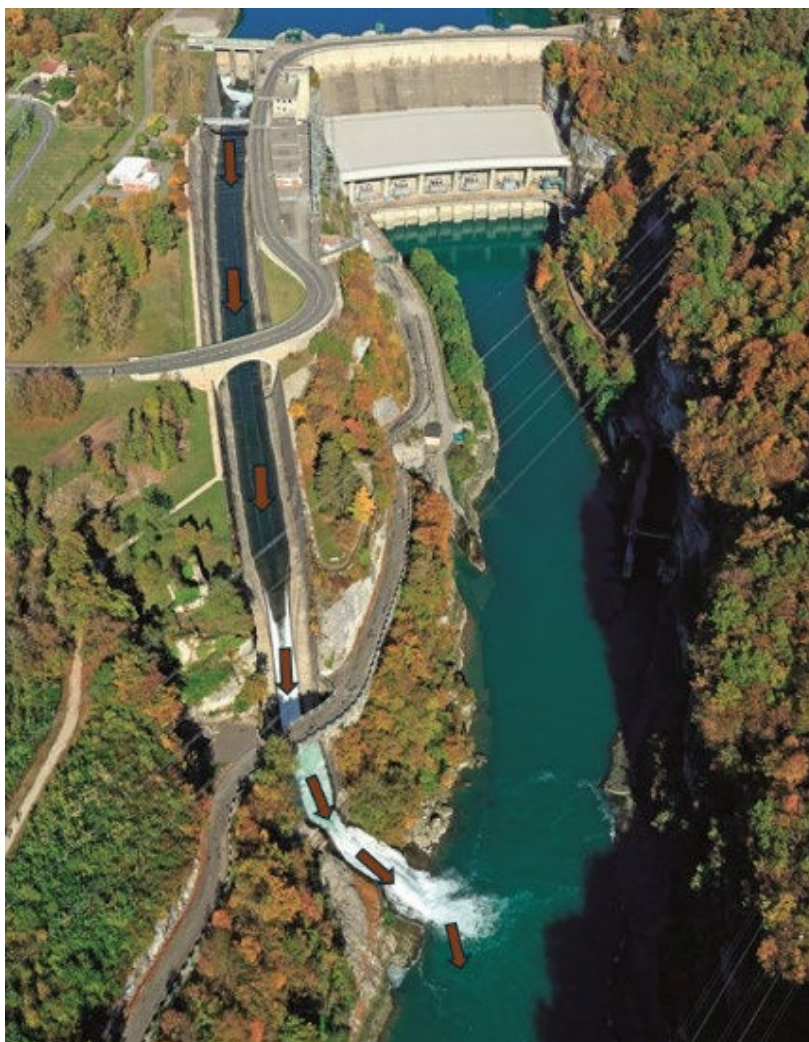
Figure 14. Restitution dans l'évacuateur de crue (Vue générale)
