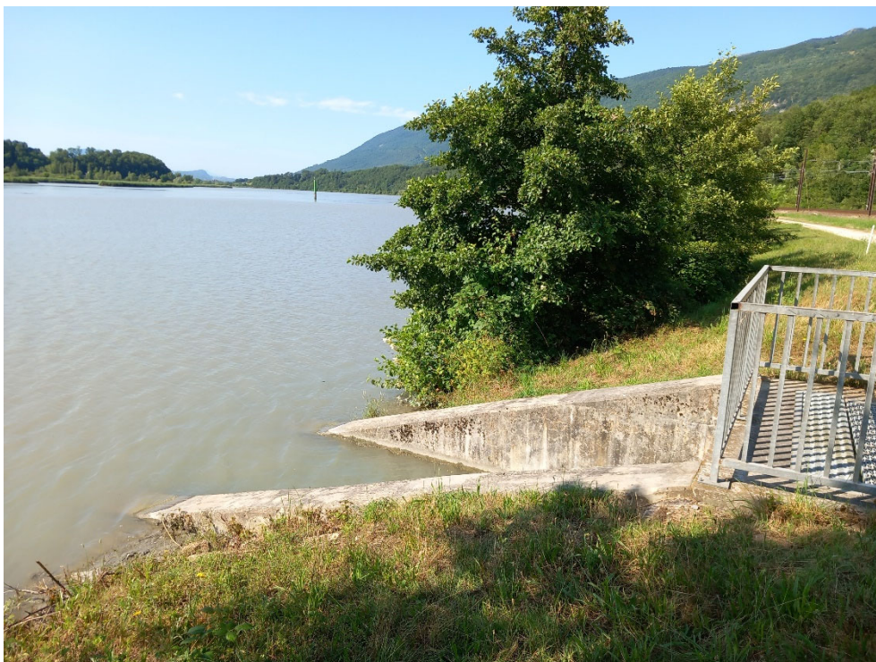
Figure 8. Vue sur la restitution de l'aqueduc numéro 4, enrochement avec strate herbacée (ACME 2024)
