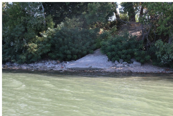
Figure 15. Berge en enrochement avec dépôts d'inertes en rive gauche
