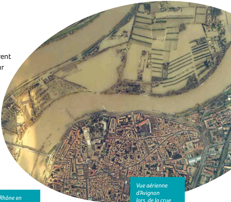
Le Rhône en crue, barrage de retenue de Vallabrègues, Gard
