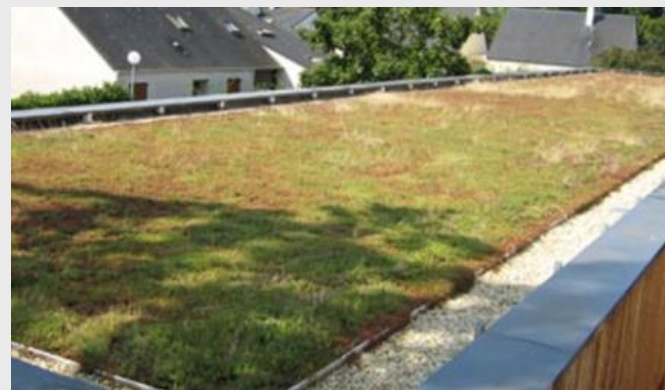
Exemple de toiture végétalisée
