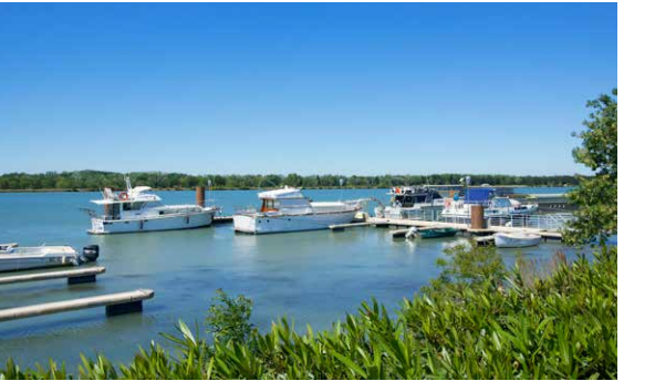
Pour répondre à l'augmentation des croisières fluviales et favoriser les visites patrimoniales, CNR a développé des capacités d'accueil des paquebots fluviaux. Elle a créé ou modernisé appontements pour bateaux à passagers et haltes fluviales sur des sites particulièrement attractifs. Elle en a équipé certains de bornes d'alimentation en électricité 100 % renouvelable qui réduisent fortement les émissions de CO 2 et évitent aux riverains les nuisances sonores et olfactives des groupes électrogènes embarqués.
