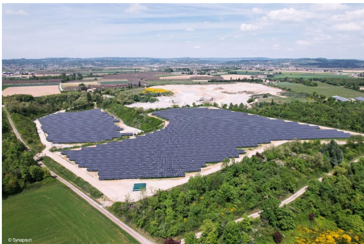
Vue aérienne du parc photovoltaïque de Saint-Paul-lès-Romans – Crédit photo : Synapsun
