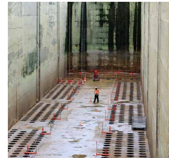
Inspection d'un sas d'écluse
