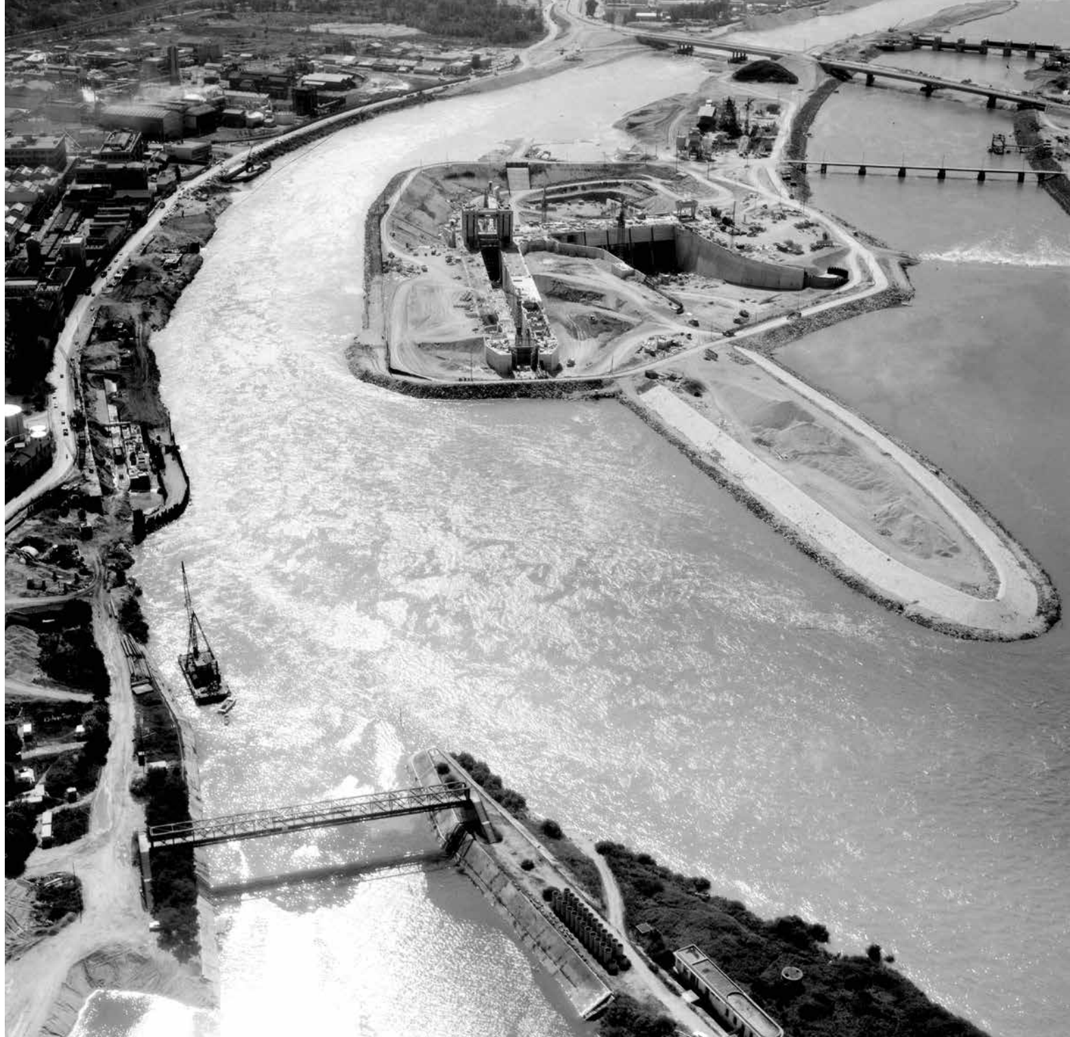
Aménagement de Pierre Bénite en construction
