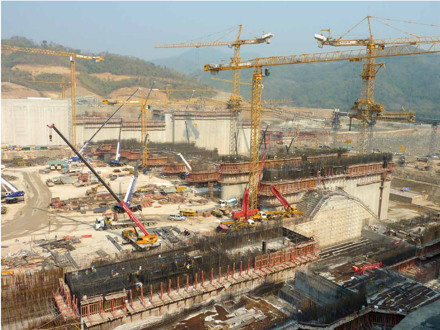
Barrage de Xayaburi en construction
