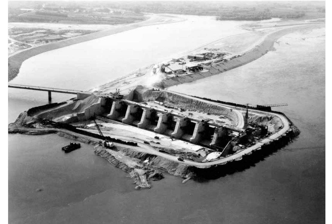
Barrage de Vallabrègues en construction
