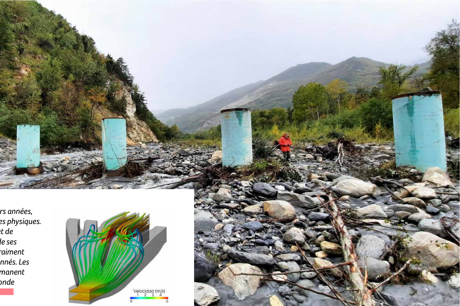
Piège à flottants de l’Arvan après réalisation
