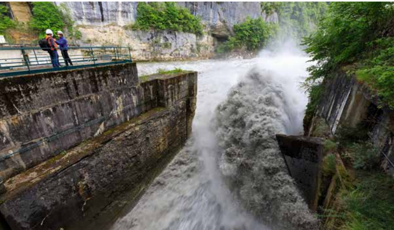
Vanne de fond du barrage de Génissiat
