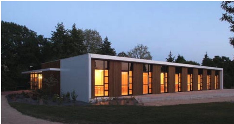
Exemple de traitement : petit volume, bâtiment préfabriqué.
