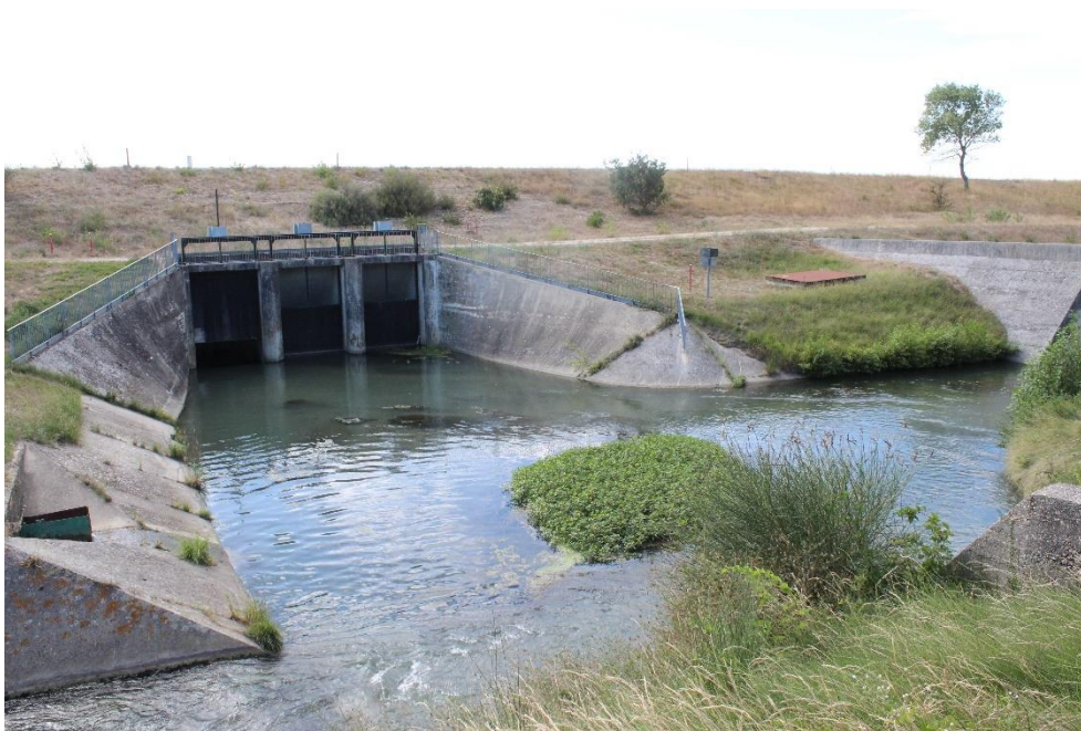
Figure 13. Accumulation de sables dans le bassin amont du siphon de la Gaffière (ACME – 2020)
