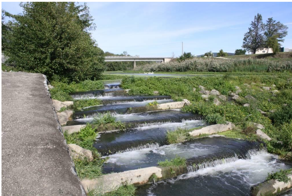
Figure 2. Aménagement piscicole du seuil du Laveyzon – CNR 2012
