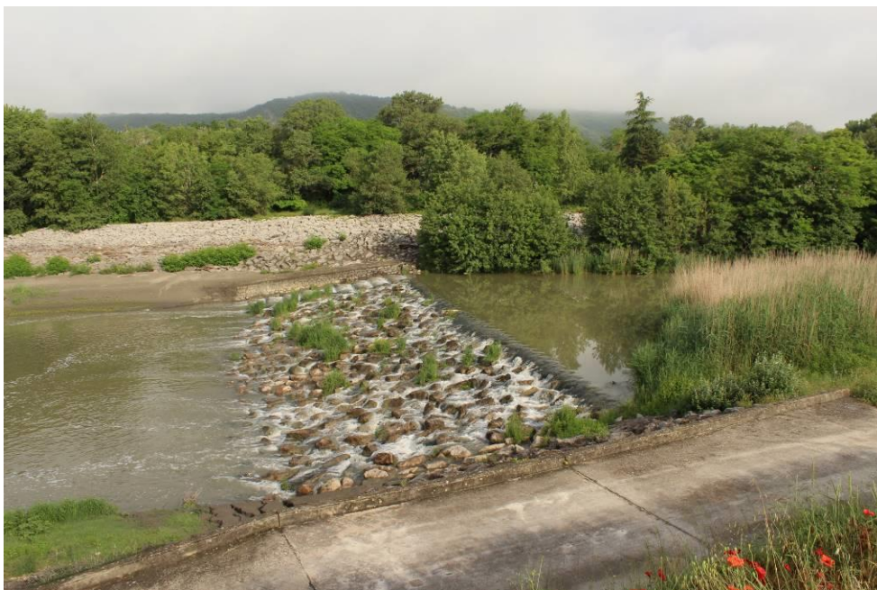
Figure 12: Vue du seuil et de la passe à poissons depuis la berge rive gauche du Laveyzon (ACME 2018)
