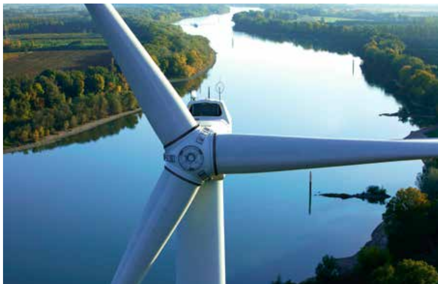
Parc éolien de Beaucaire
