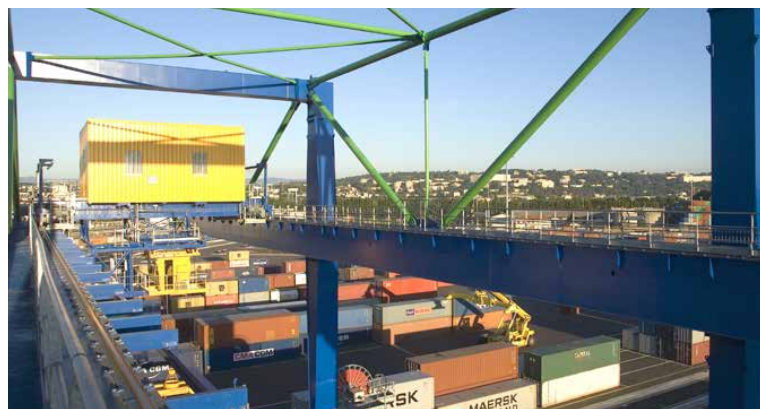
Portique de manutention du Port de Lyon Édouard Herriot
