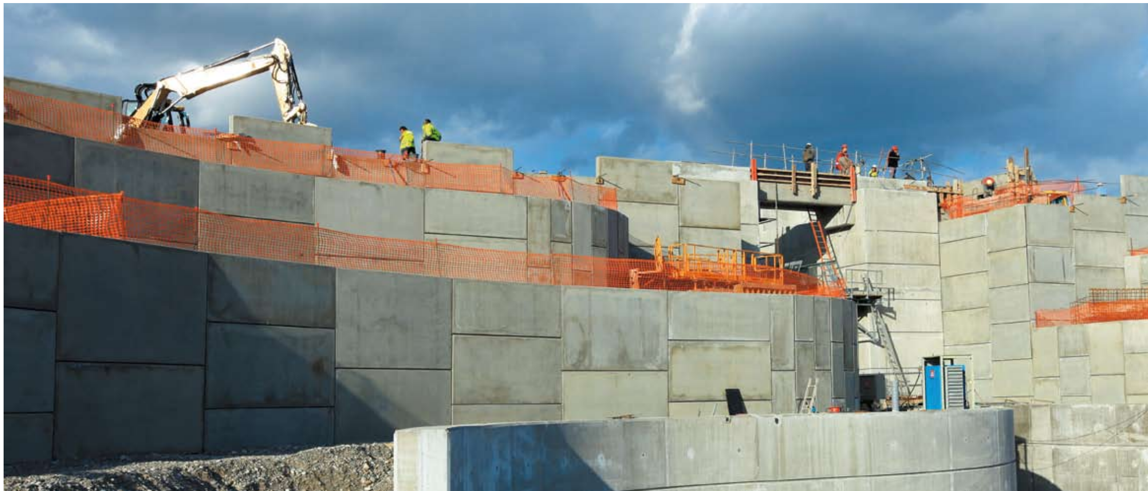
Chantier des écluses de Chautagne
