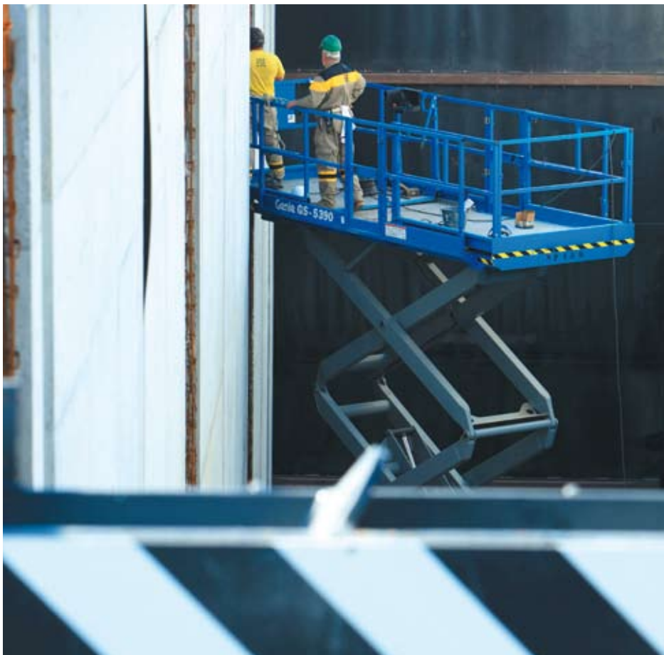
Chantier des écluses de Chautagne
