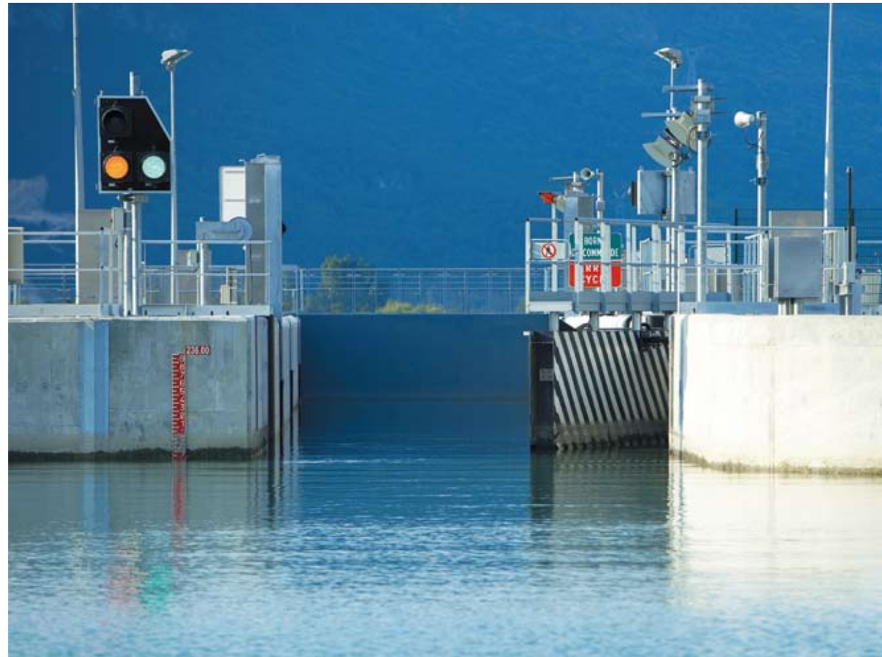
Arrivée sur l'écluse de Belley
