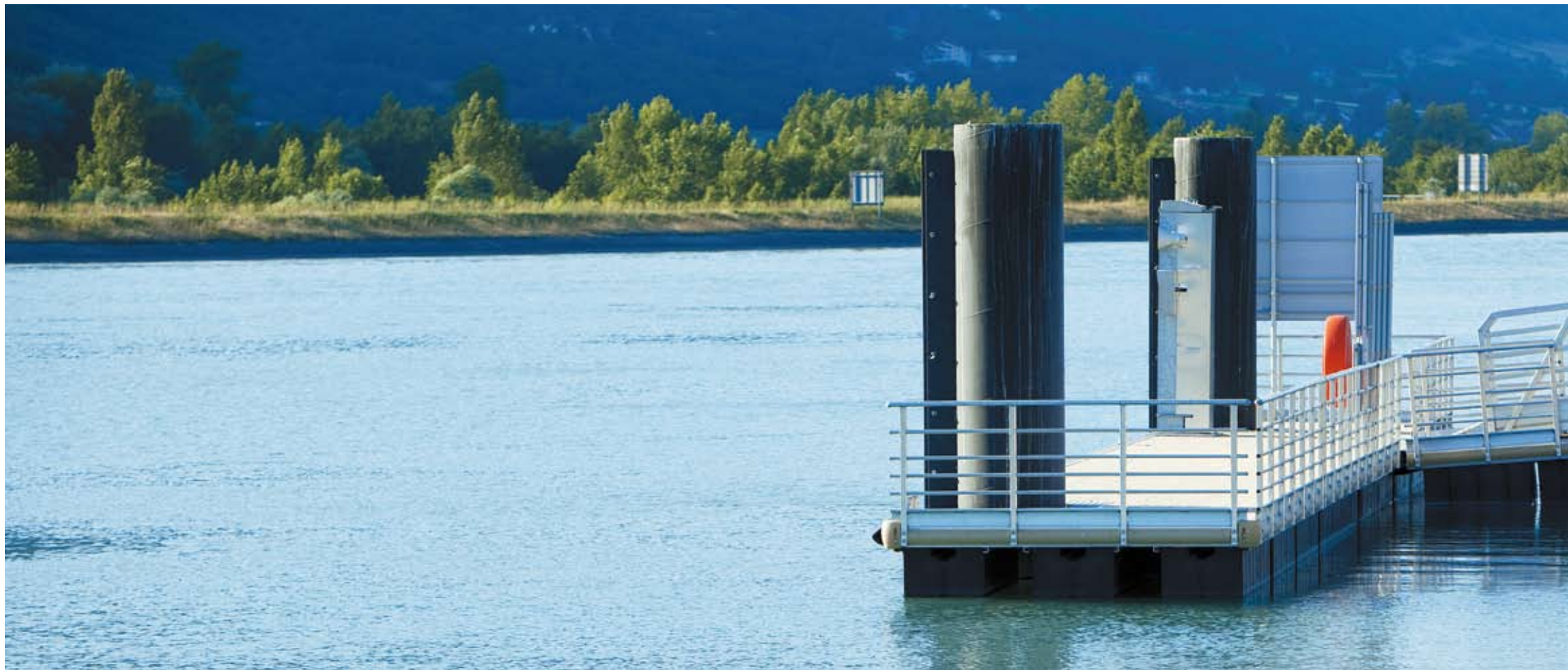
Ponton permettant les manœuvres d'éclusages - Belley
