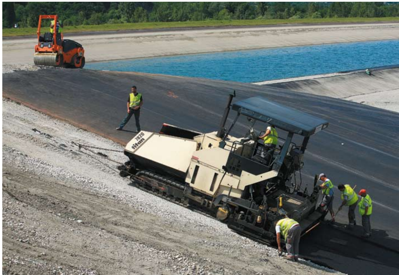
Travaux d'étanchéité du canal d'aménée de l'écluse de Chautagne
