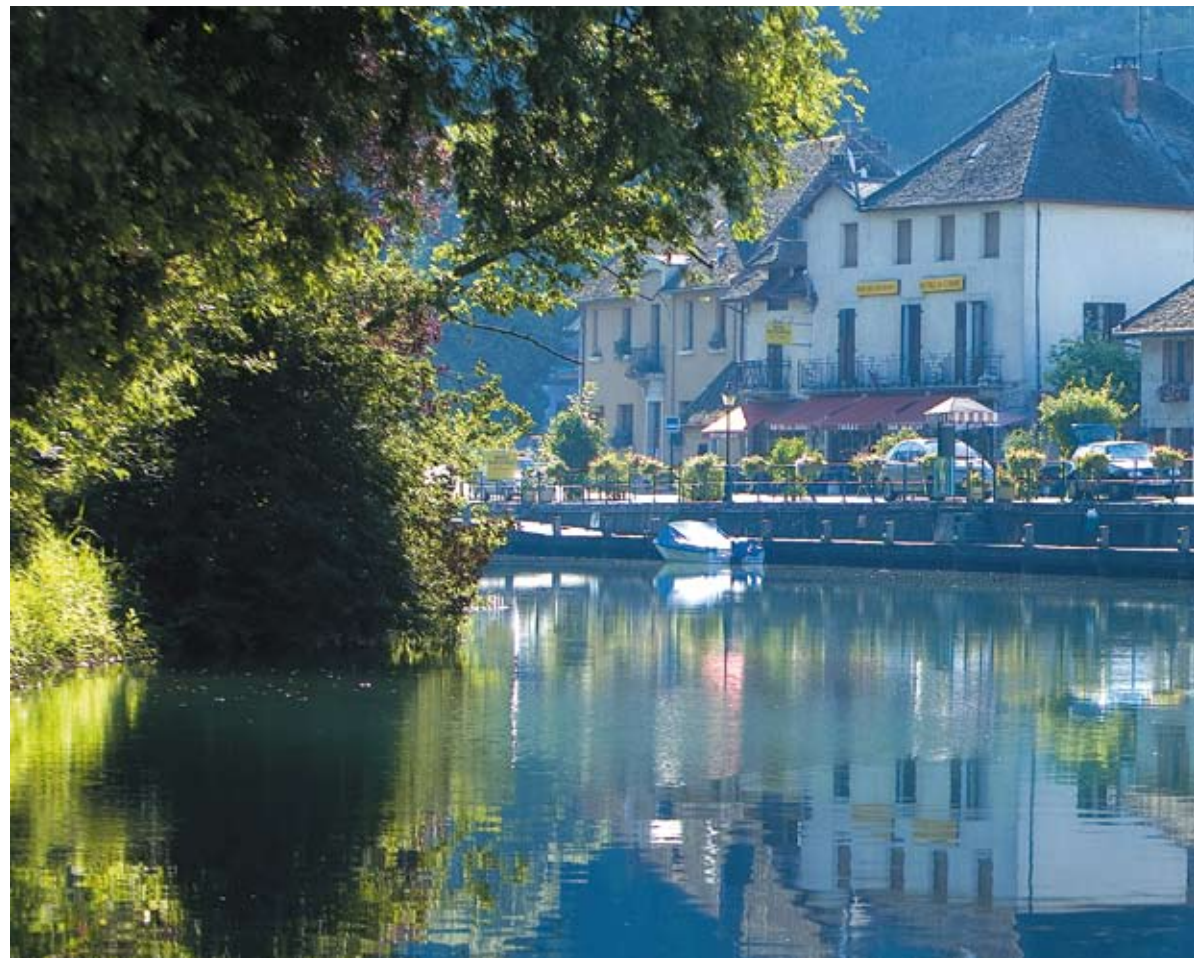
Canal de Savière à Chanaz (Savoie)
