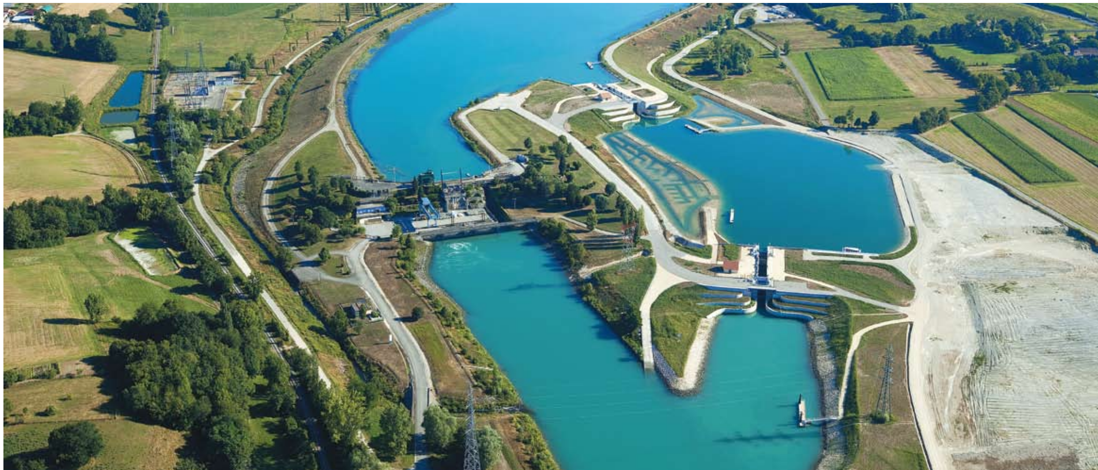
Vue aérienne de l'écluse et de la centrale hydroélectrique de Chautagne
