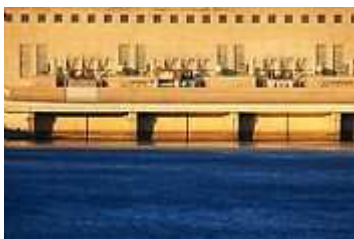
Centrale hydroélectrique de Montélimar
