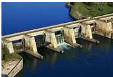
Barrage de Villeneuve-lès-Avignon
