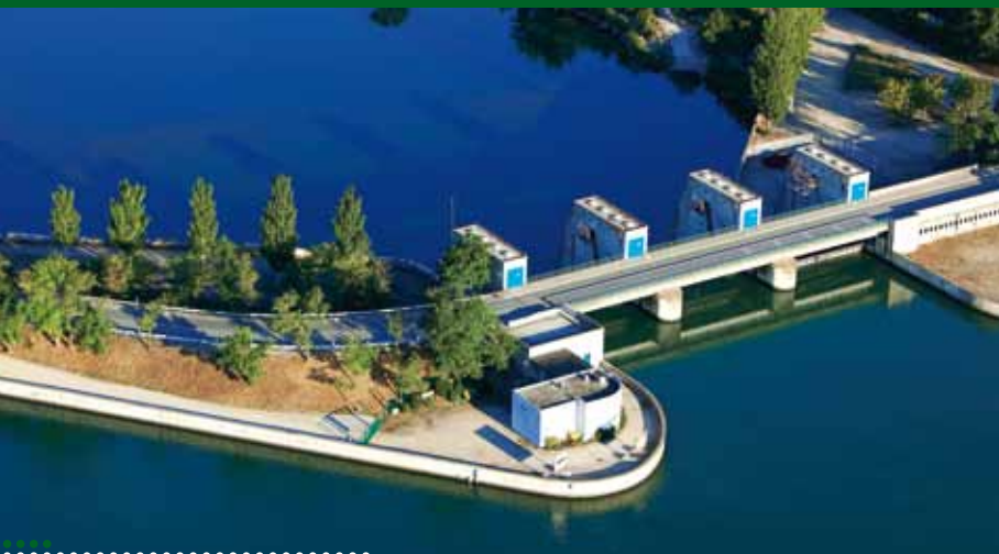
VUE AÉRIENNE DU BARRAGE DE L'ISÈRE - AMÉNAGEMENT DE BOURG-LÈS-VALENCE
