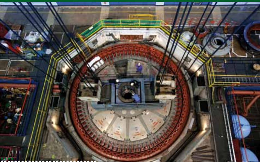
INSTALLATION DU ROTOR SUR LE GROUPE 3 DE LA CENTRALE DE LOGIS-NEUF
